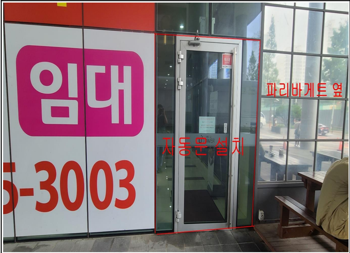
1층 판매시설 자동문 및 방풍실 설치(파리바게트 옆)
